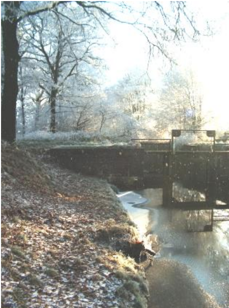
Foto P. Maessen Sluis Neers kanaal
